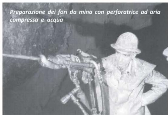
Preparazione dei fori da mina con perforatrice ad aria compressa e acqua
