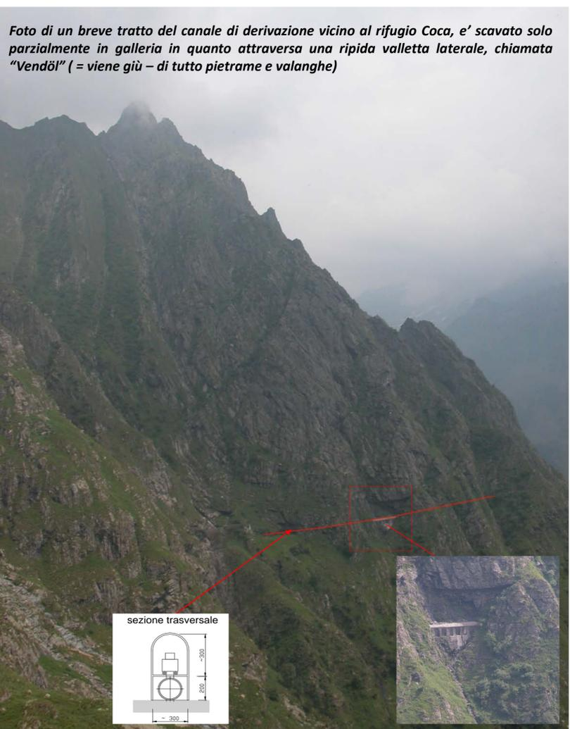
Foto di un breve tratto del canale di derivazione vicino al rifugio Coca, e' scavato solo parzialmente in galleria in quanto attraversa una ripida valletta laterale, chiamata "Vendöl" (= viene giù - di tutto pietrame e valanghe)
